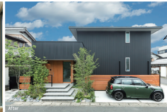
▲玄関を東へ移動し、外階段もなだらかに。既存外壁の上からカバー工法により金属サイディングを施工。スタイリッシュモダンに生まれ変わりました。
