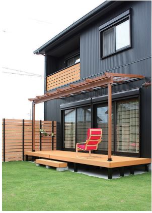
(上)外壁はメンテナンス性を考慮して金属サイディングを採用。ブラックのサッシに赤い玄関扉とレッドシダーの格子がポイントとなり、新しいフォルムの中にも、落ち着いた赴きを感じる仕上がりとなっています。 (左)黒い外壁に映える鮮やかな芝生はご自身で施工されたもの。LDKからつながるウッドデッキは、休日の憩いの場所となりお二人を癒してくれそう。
