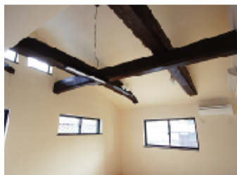
(上) 前の家に使われていた梁は、煤を落とすために丹念に洗い、新築に合うよう加工を施し、古木色の塗料を塗布しています。
