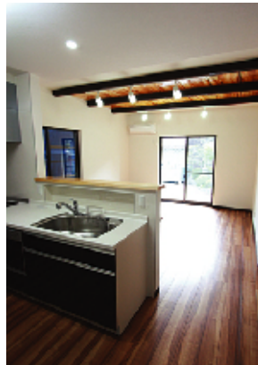
(右上) 1階のLDK。前の家の梁を化粧梁に、天井に使われていた板は磨きをかけ光沢を出して、天井のアクセントとして再利用しました。足元にはカラダに優しい温水床暖房を設置しています。
