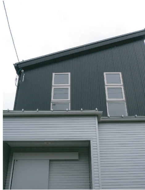
(右上) 外観、内観とも個性的なアクセントになる連装窓。 (左上) ガルバニウムの外壁。断熱材のサンドイッチされた商品で断熱性能もバツグン。耐久性にも優れています。
