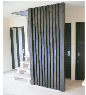
(右上) 構造上抜けない柱を利用した目隠し壁を格子状にしました。 (左上) コテ柄の2色で仕上げられたダイニングの壁
